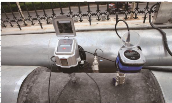
郑州一次主管网检测项目
